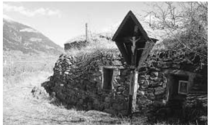
Der Trinkwasserspeicher in Göflan
